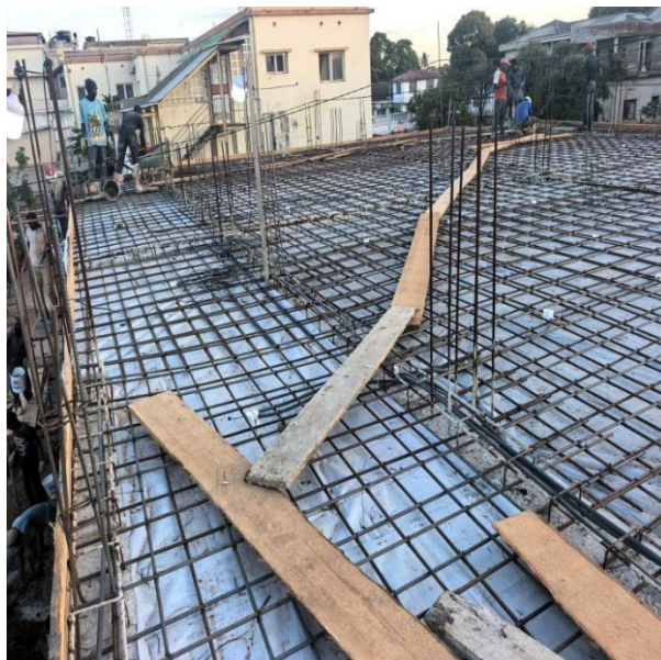
Posa dell'armatura metallica e delle tavole di legno lungo il perimetro della sala
