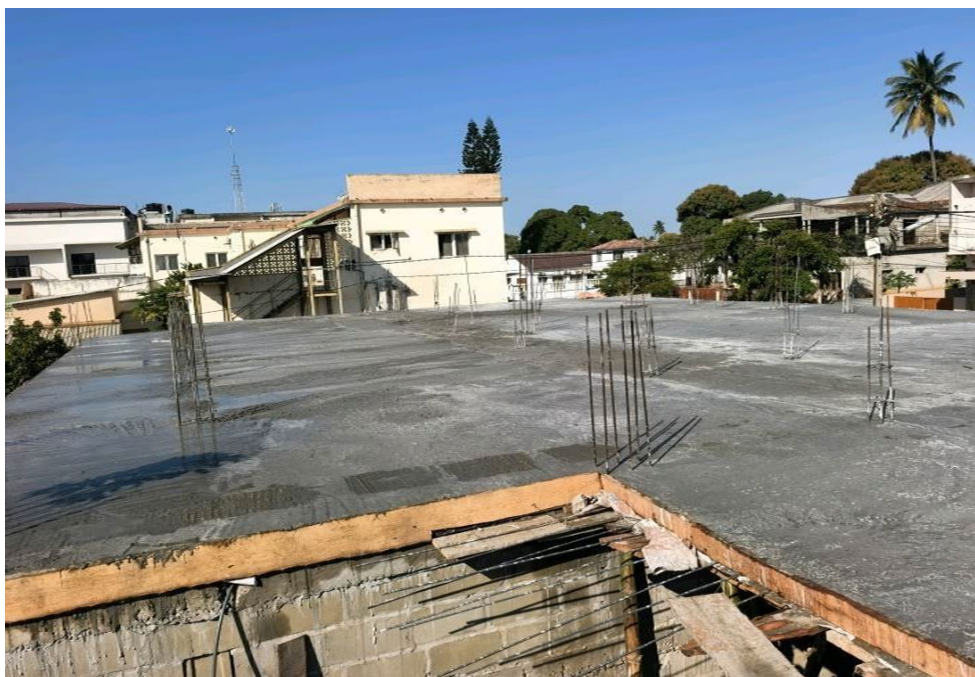
Veduta della soletta dalla parte in cui si eleveranno le scale per l'accesso al piano uffici
