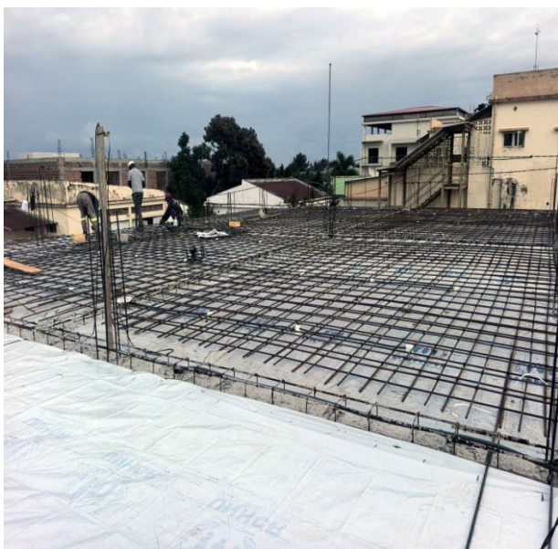
Posa dell'armatura metallica e delle tavole di legno lungo il perimetro della sala
