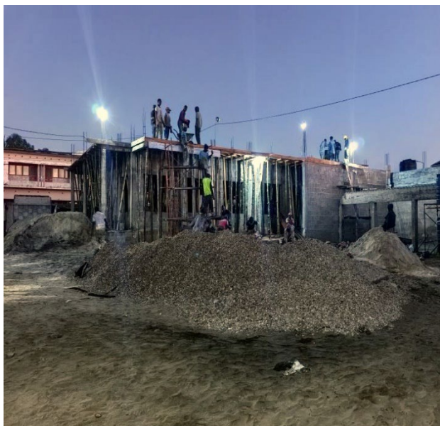
Riempimento della soletta e livellamento con malta
