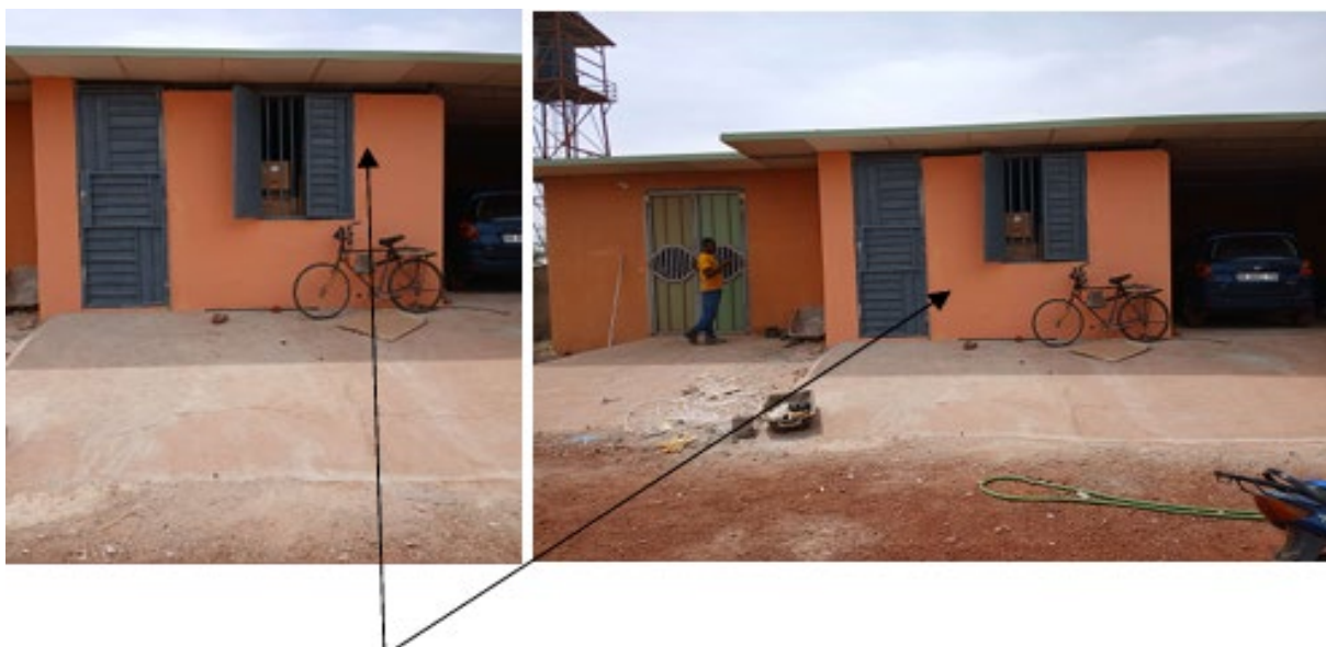
La sala tecnica in cui è stata installato la centrale fotovoltaica
